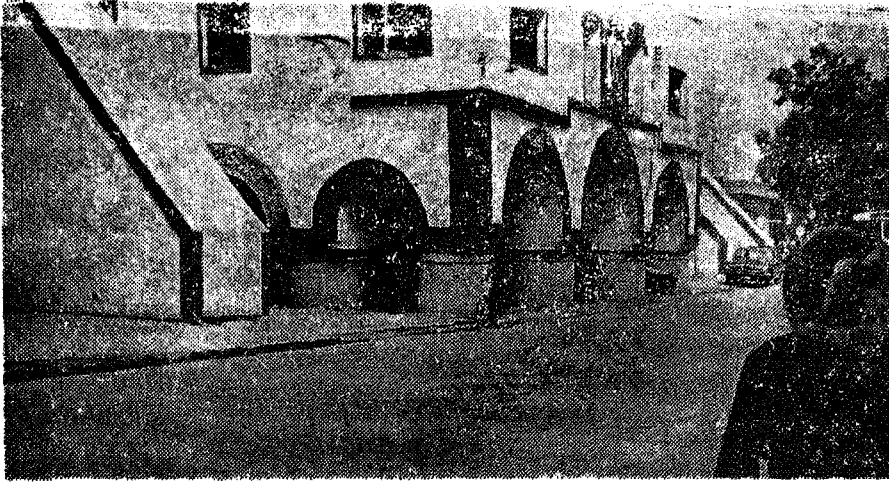
صورة - ٥٧ واجهة مدخل قشلة كركوك
