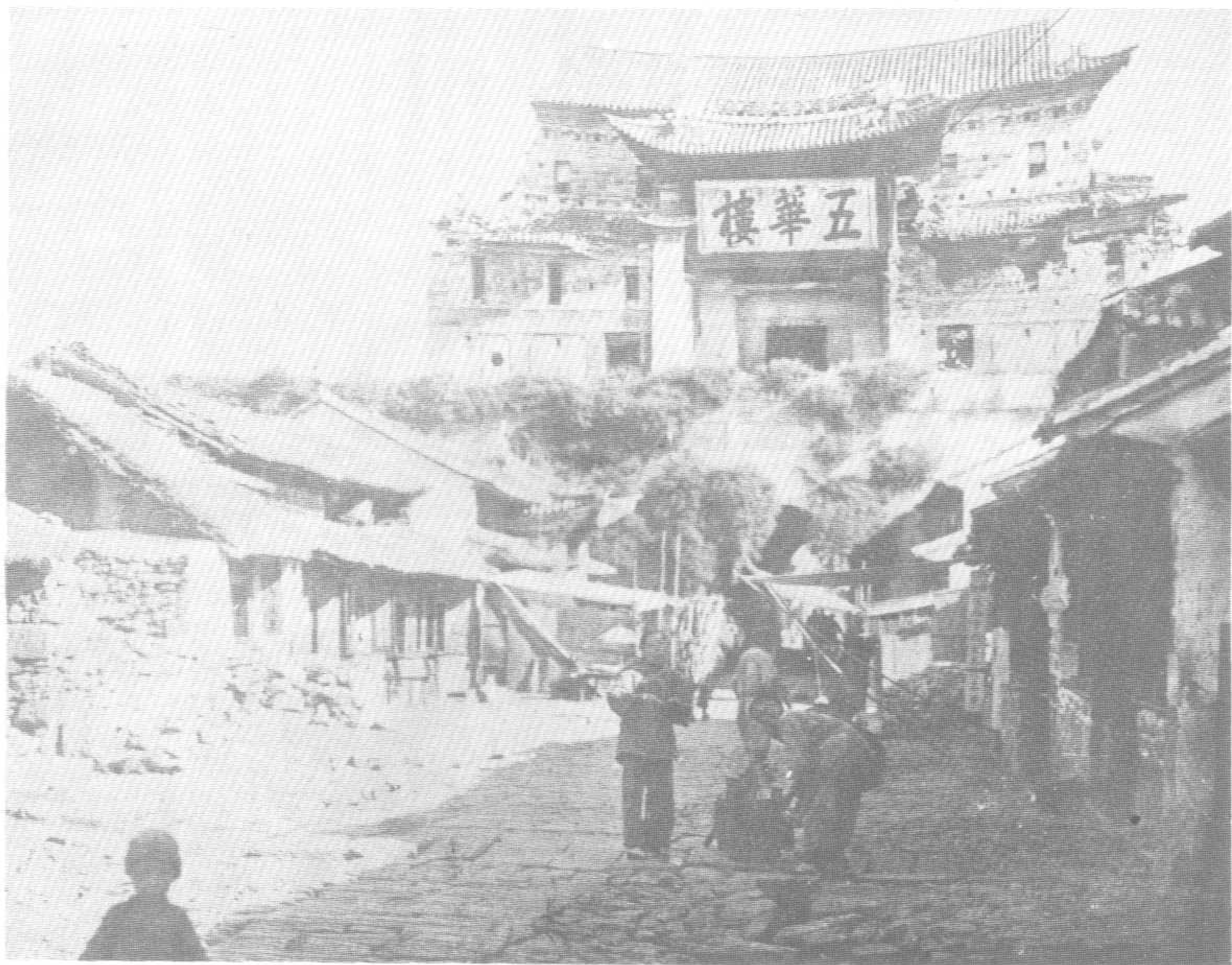
387 五華樓 元世祖滅大理時，曾駐兵樓前。
