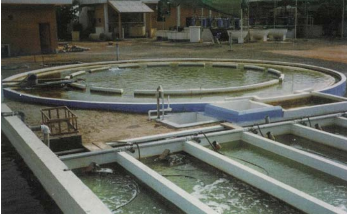
الشكل (٧-٨): حوض التفريخ الدائري وأحواض تربية اليرقات المستطيلة في نظام باواباب(مركز المزارع السمكية - جدة)
